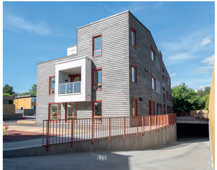
For å slippe å mure om vinteren, valgte utbyggerne å gå for skjermtegl i fasadene.
