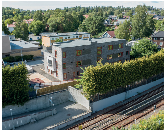
Prosjektet er gjennomført på en trang tomt like ved T-banen.
